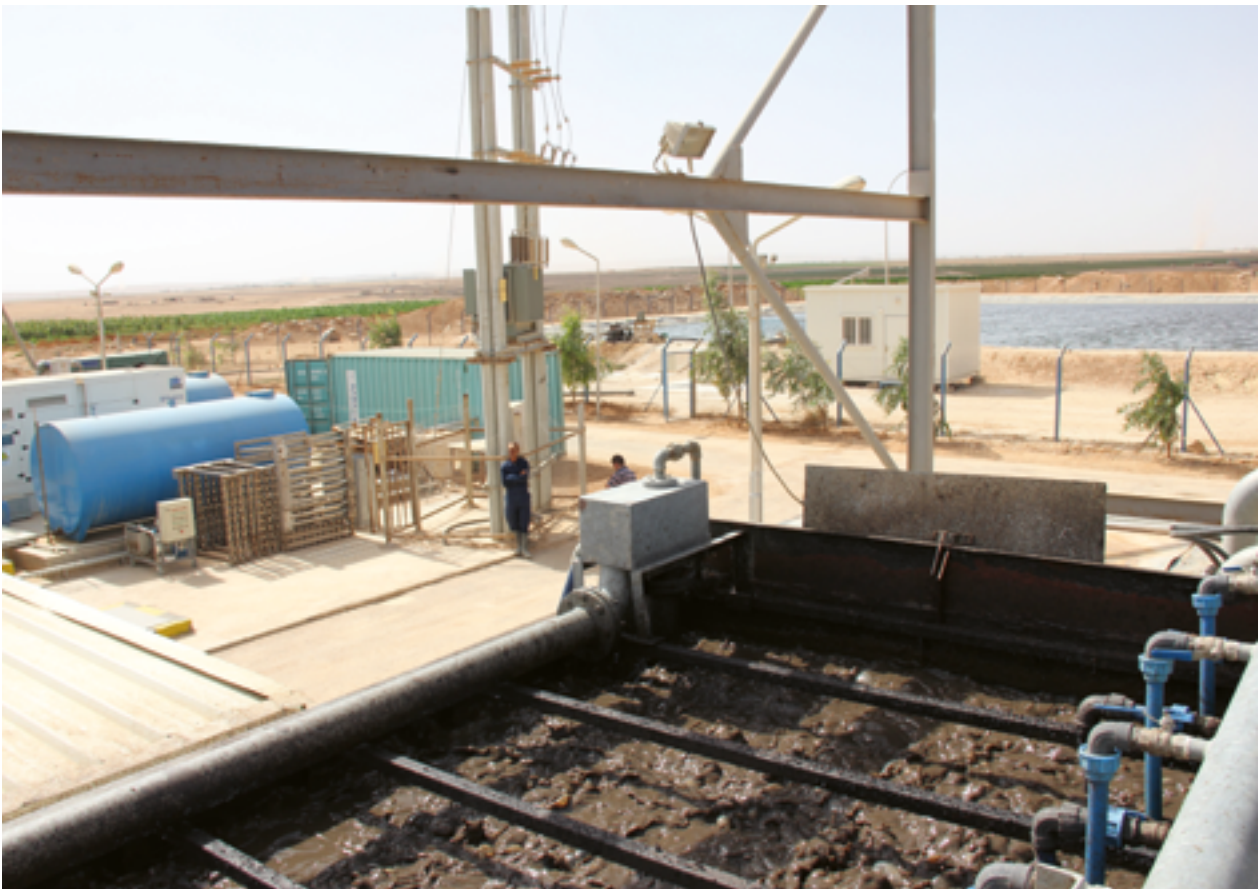
Membranbioreaktor mit anschließendem Klärteich und Wiedernutzung des geklärten Abwassers im Za'atari Camp, Jordanien
