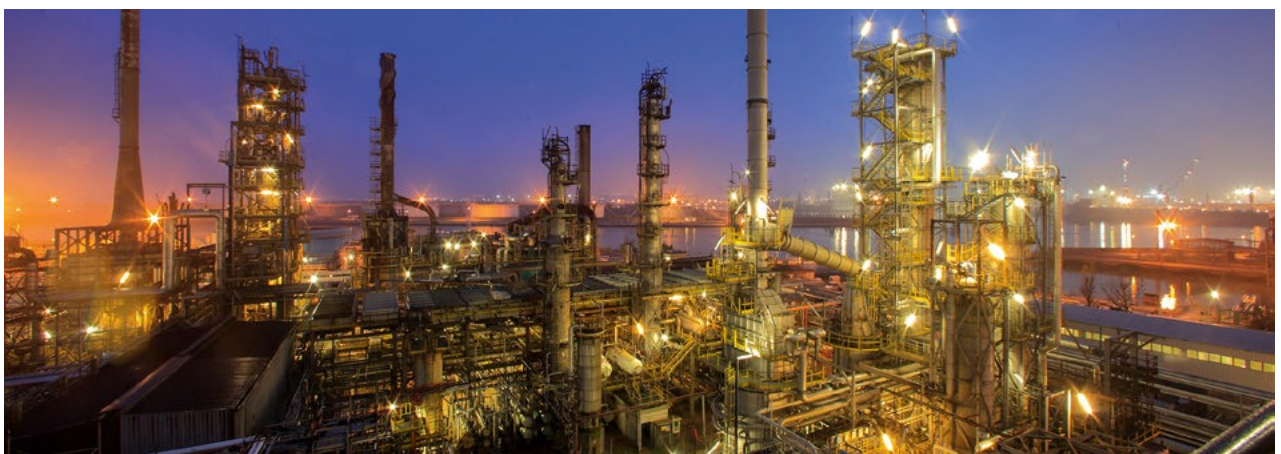
Die Geschäfte der Ölkonzerne sollen zukünftig mit biologischen Ressourcen befeuert werden. Die umgebaute Raffinerie des italienischen Ölkonzerns Eni in Porto Marghera produziert nun Biokraftstoffe.
