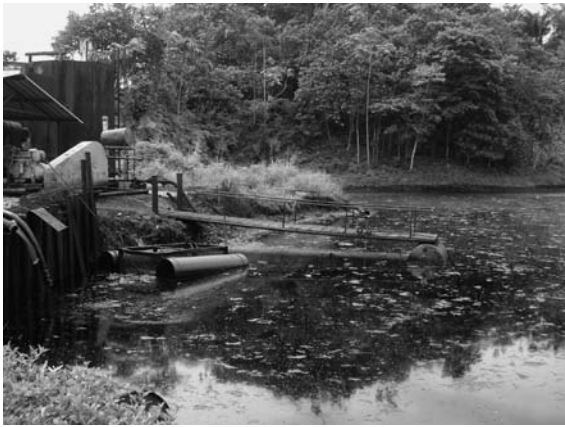
Offene Rückhaltebassins mit Erdöl-Wasser-Gemisch in Sucumbíos, Ecuador
