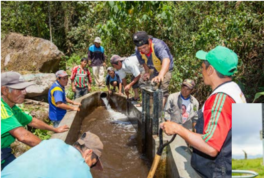
In Pandachí/Peru reinigen Bauern eine Quelfassung. Sie sammelt das Wasser aus einer Quelle in einem Betonbecken. Dort können sich Sedimente absetzen, ehe das Wasser über Rohre zu den Feldern geleitet wird.
