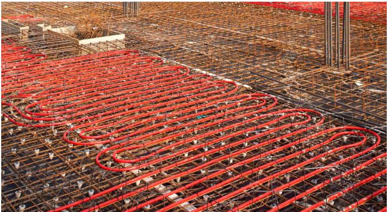
Leitungen für die Betonkernaktivierung aus der Bauphase
