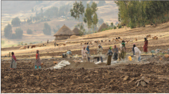
An den Bauarbeiten für das neue Kanalsystem sind die Bewohnerinnen und -bewohner des Dorfes Anberbir beteiligt.
