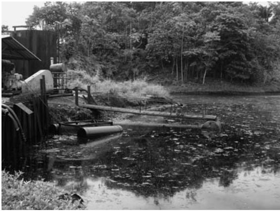
Offene Rückhaltebasins mit Erdöl-Wasser-Gemisch in Sucumbíos, Ecuador
