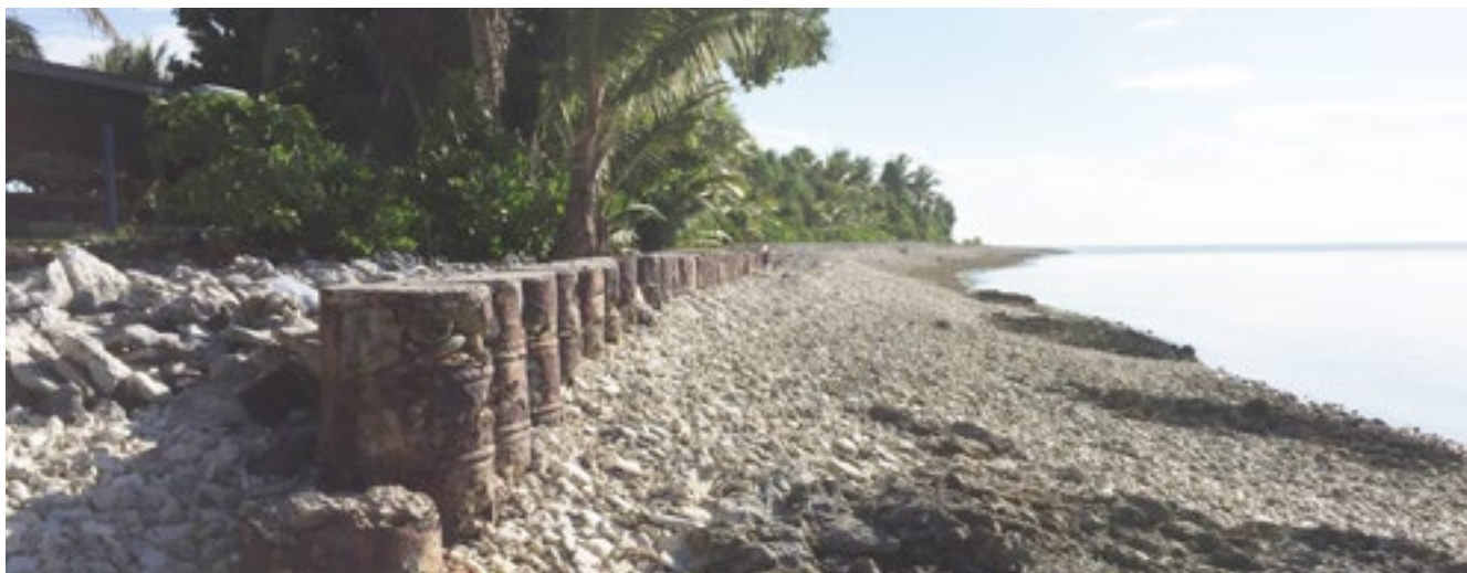
Um die Insel vor dem steigenden Meeresspiegel zu schützen, werden auf Tuvalu/Fidschi künstliche Dämme durch zementgefüllte Tonnen errichtet.
