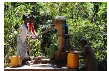
Sauberes Wasser Der Bau von Brunnen, wie hier im Kirchenwald von Taragedam, ist eine weitere Komponente der Arbeit von EOC-DICAC.
